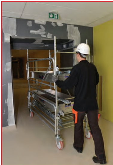
Passage dans les portes de 0,83 m.
